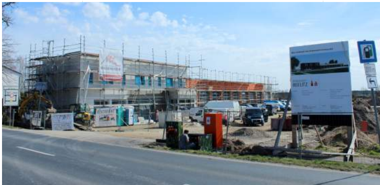
Stand der Bauarbeiten an der neuen Stützpunktfeuerwehr im April. Foto: Lähns
